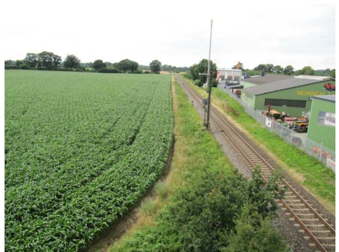
Zu erstellender Weg entlang der Bahnstrecke
