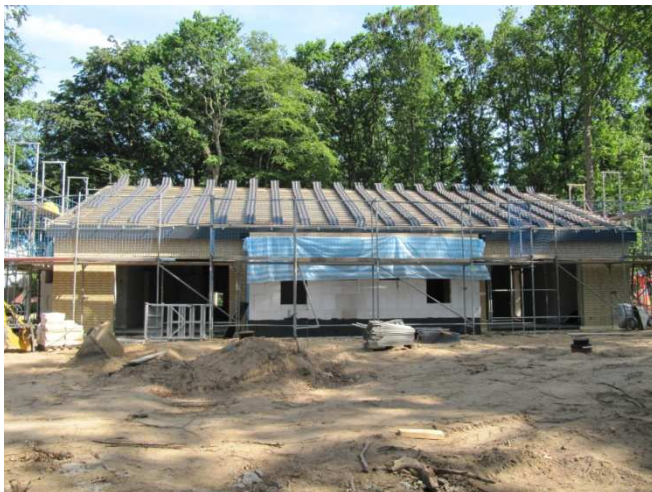
Bau der neuen Krippe in der Parkallee
