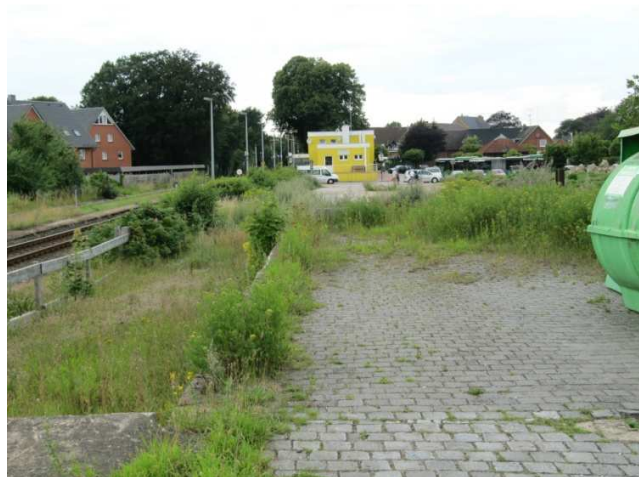
Zustand der Ladestraße Juli 2010
