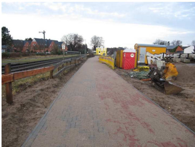
Der fertiggestellte Weg zwischen Bergstraße und Bahnhof
