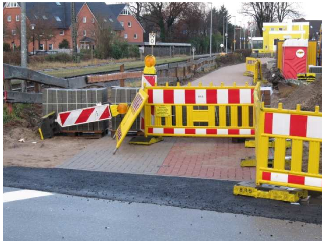
Aufgestellte Barrieren aus Richtung Bergstraße
